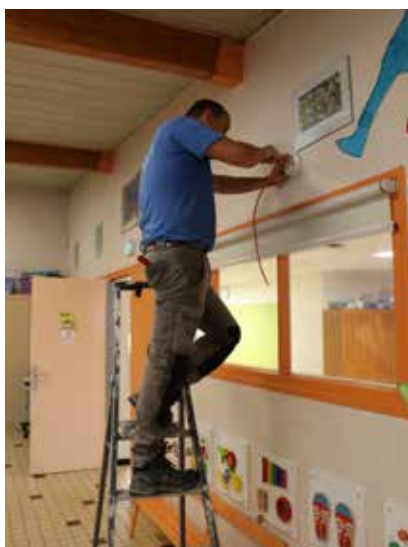
Remplacement de matériel
