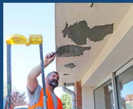
Maçonnerie de la toiture, remise en peinture et travaux de menuiserie - Ecole Brel
