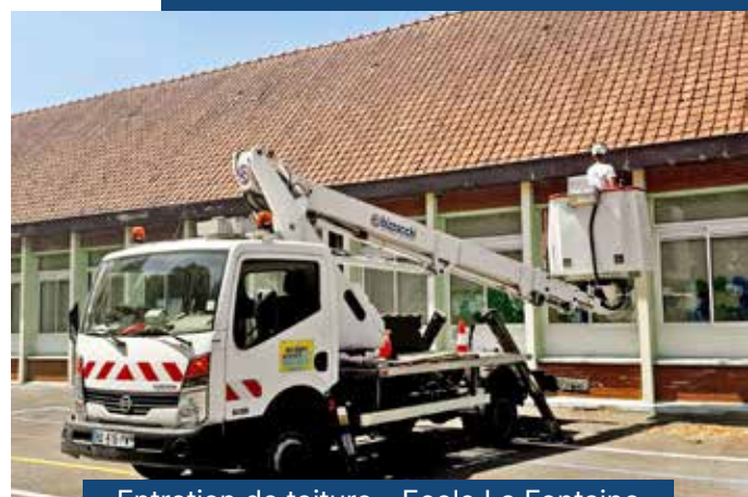
Entretien de toiture - Ecole La Fontaine
