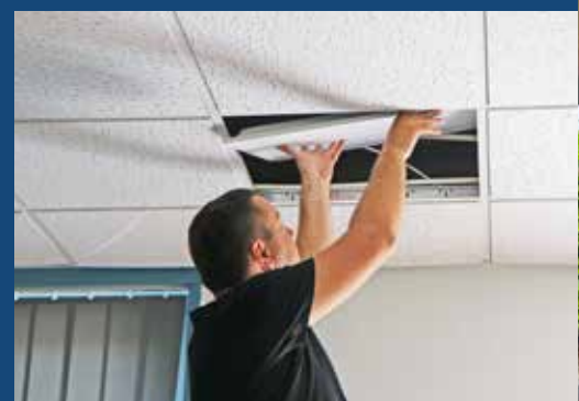
Remplacement de luminaires - Ecole Pantigny
